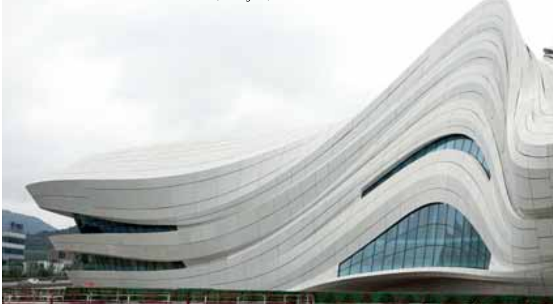
MeiXiHu International Culture and Art Center, Changsha, Cina - Calcestruzzo rinforzato con fibra di vetro
